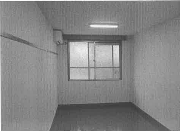
(平成26年3月寮生個室改修工事実施)
