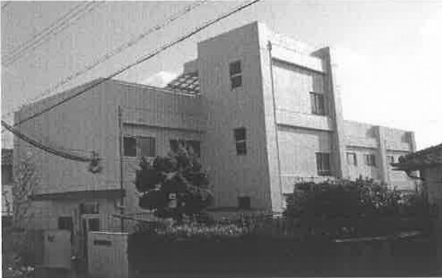
(平成28年7月寮外壁改修工事実施)
